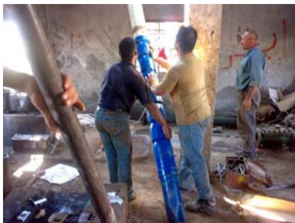
ポンプ据付 (19-19/005A, Ein Al Byhda) (農業用井戸修復パイロットプロジェクト)
