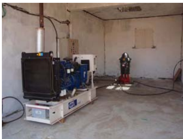
井戸改修後 (19-17/055, Jiftlik) (農業用井戸修復パイロットプロジェクト)
