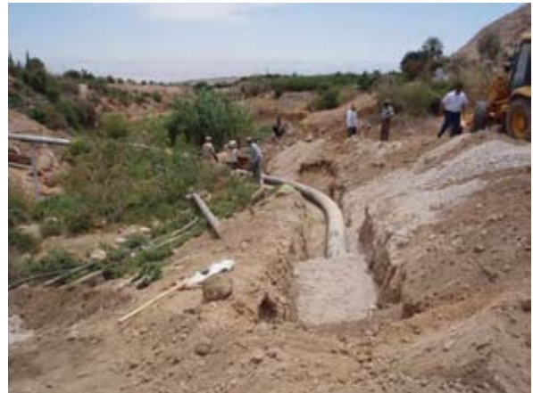
ヌエイマ湧水パイプ敷設 (湧水導水システム改善パイロットプロジェクト)
