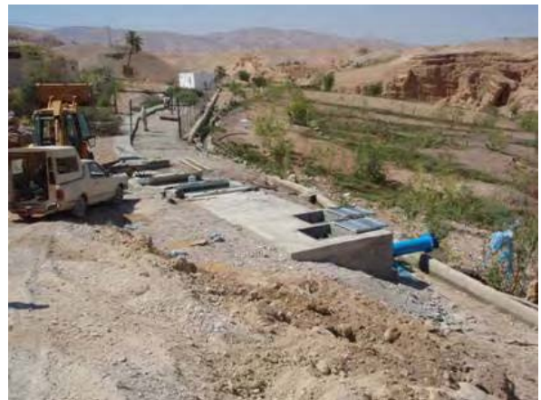
ヌエイマ湧水上流部改修後 (湧水導水システム改善パイロットプロジェクト)
