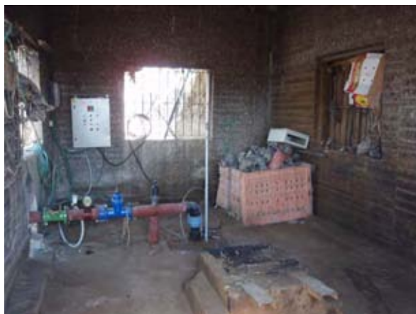
井戸改修後 (19-17/054, Jiftlik) (農業用井戸修復パイロットプロジェクト)
