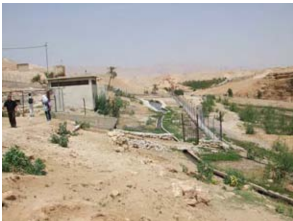
ヌエイマ湧水上流部改修前 (湧水導水システム改善パイロットプロジェクト)
