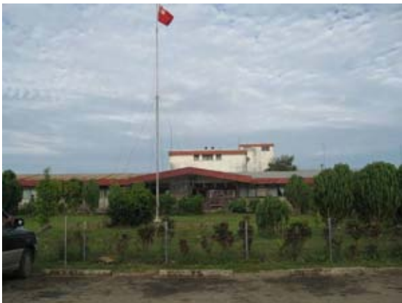
現在の外来入口。後ろに見えるのは解体予定の旧病棟
