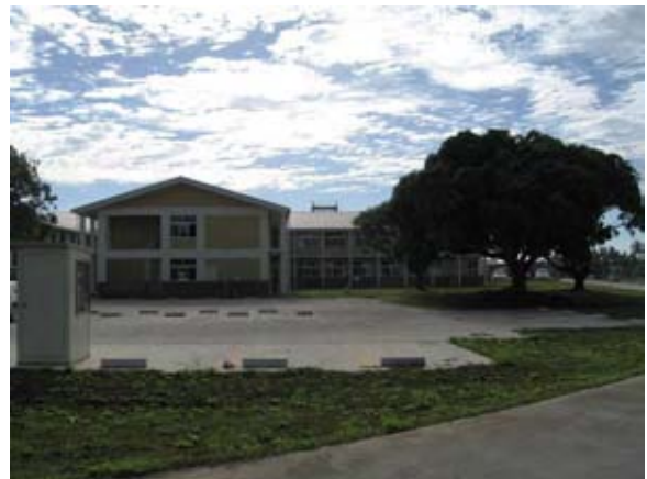
Package B1 で建設された病棟（南西側から見る）
