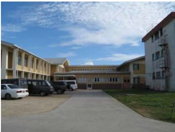
Package B1 で建設された施設。正面の平屋部分は産科、左側は病棟（2階建て）、右側は中央診療棟（2階建て）。右手前は解体予定の旧病棟（3階建て）
