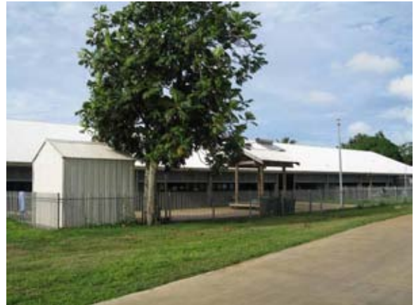
Package A で建設された精神病棟（裏側から見る）
