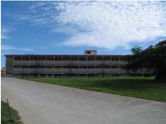
解体予定の旧病棟（3階建て）
