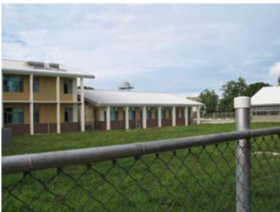
Package B2 で建設された隔離病棟（平屋部分）。左側は病棟（2階建て）
