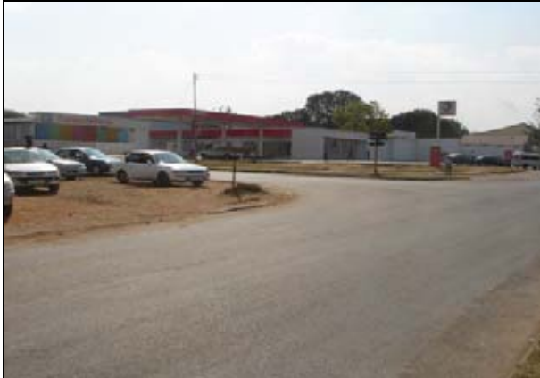
N1：ビタンダ道路 現地政府によりオーバーレイ補修実施
