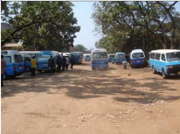
K6: マツカ道路 全面破損、走行性がかなり悪い
