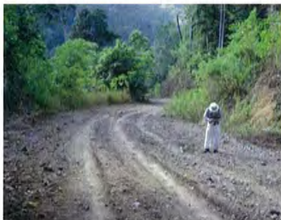
対象道路急勾配 (15%以上) 区間 (Sta. 9km)
