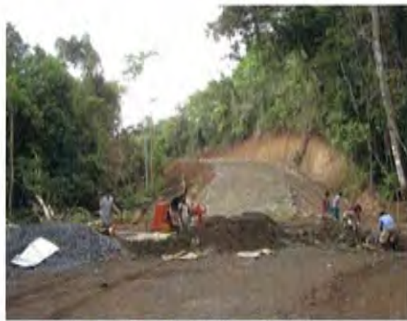
対象道路改修工事状況 (Sta. 4km付近)
