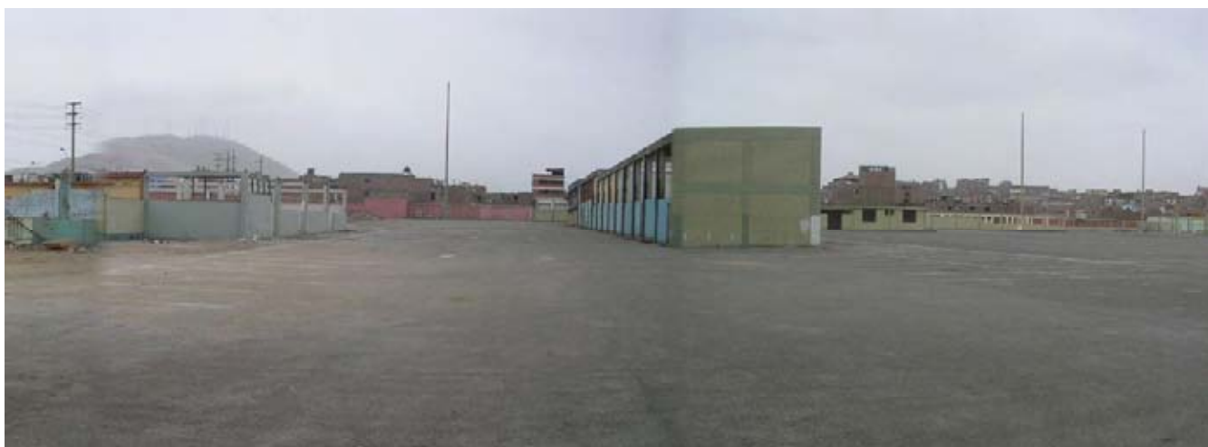
計画敷地内観-2:西側(既存建物及び地下工作物が多数残っている)
