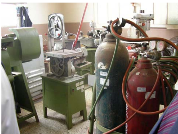
義肢装具製作室（製作機械、溶接用ボンベが多く、作業スペースが不足している）
