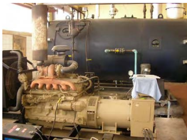
機械室：ボイラーと発電機 （機械類は古く故障が多いため、病院機能に支障が出ている）
