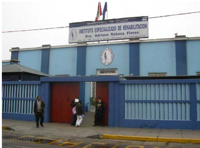
建物外観：メインエントランス（患者はサブエントランスを利用しており、職員のみ正面玄関を利用している）
