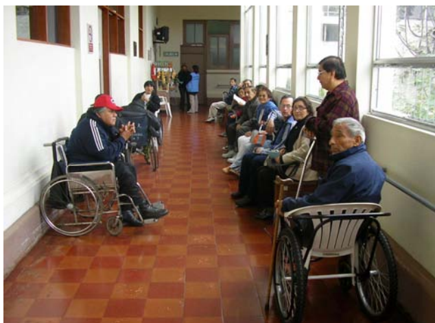
運動療法室前の廊下（運動治療を待つ患者が廊下にいるため、車椅子の使用に不便である）
