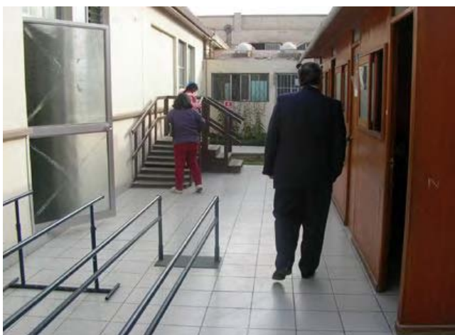
知的障害社会適用訓練室 （スペースの不足から屋外に訓練室を増築すると共に、運動治療室が狭いため、中庭で運動訓練を行っている）
