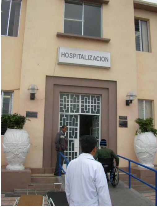
病棟外観：正面入口（入口は狭く、スロープが急勾配である）
