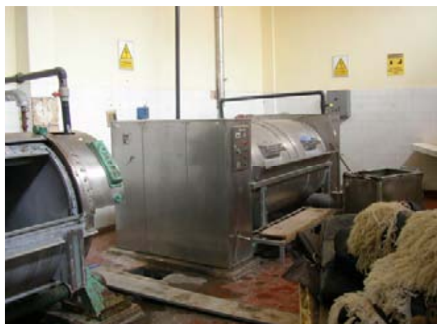
洗濯室（古い洗濯機が多く、故障のために病院機能に支障をきたしている）
