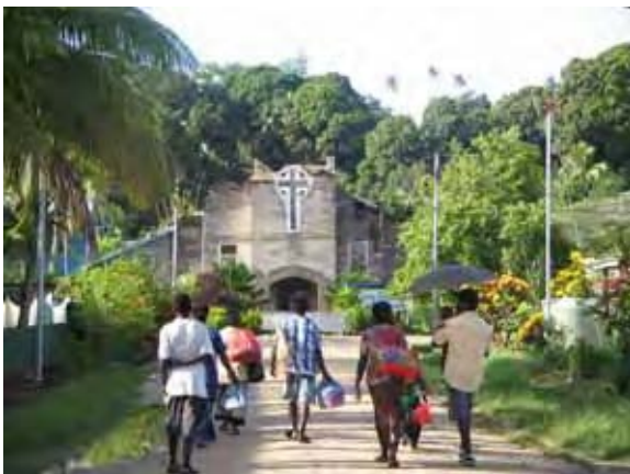
写真-21：ギゾ市教会 地震によって壁が一部崩壊している。
