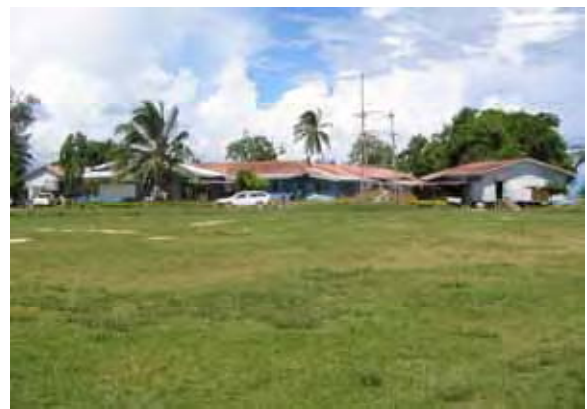
写真-20：敷地 全体的に、殆ど平坦な空地である。
