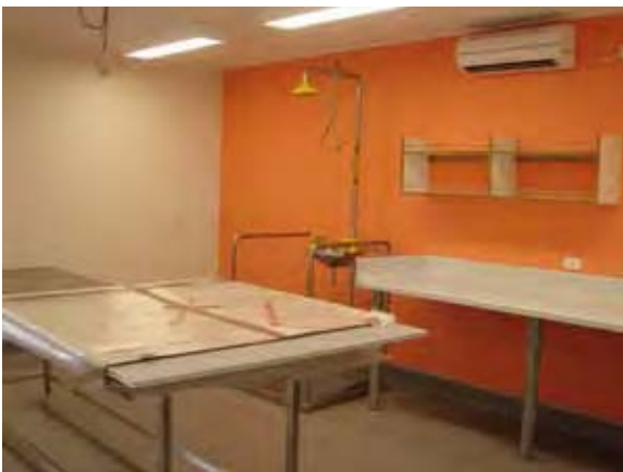
写真-17：マラリアセンター 新研究棟内部： 乾式の工法である。 不特定多数の利用する施設では脆弱である。
