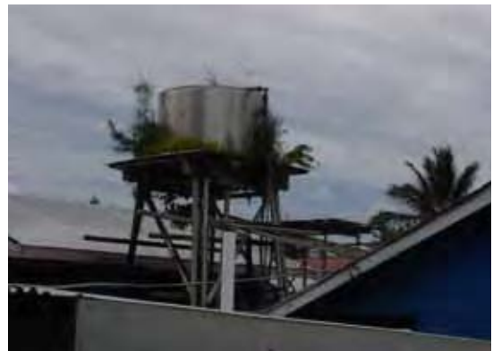
写真-4：草の生えた高架水槽 市水の信頼性が低く、天水を飲料に使用しているが、インフラには衛生上の問題がある。
