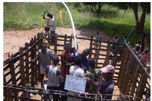
Afridev ポンプの揚水管(PVC)を修理している様子
