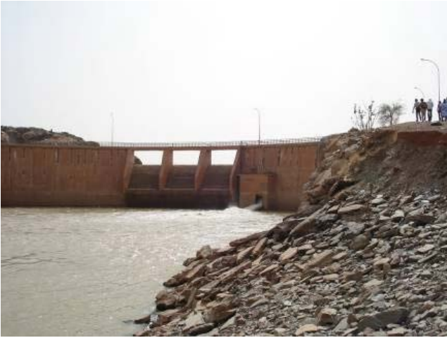
写真1 フーム・グレイタダム（下流より）
