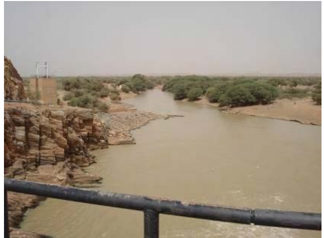
写真4 ダム堤頂より下流
