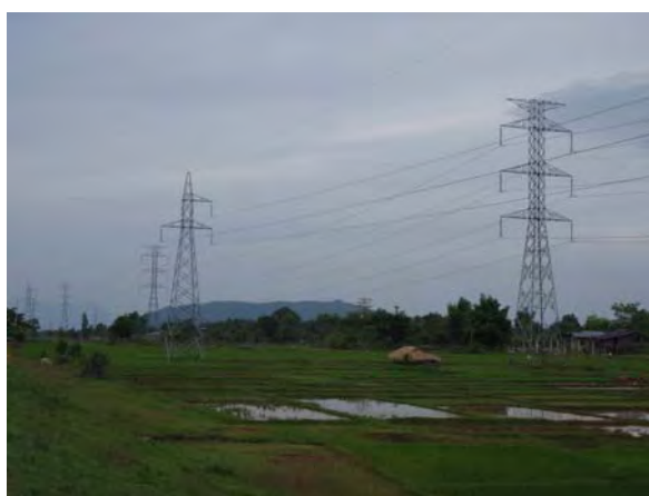
右が 500kV 送電鉄塔 (タイ輸出用) 左が 115kV 送電鉄塔 (国内基幹用)
