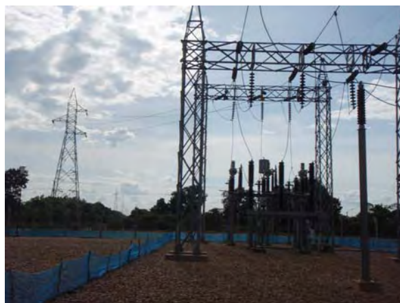
Kengkok S/S 引込鉄塔とガントリー 左側に 2 回線の引き込みスペースあり
