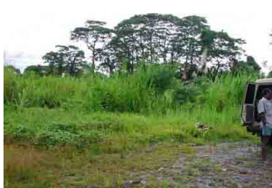
1. Bakanovi 橋 左岸側橋梁へのアプローチ部分
