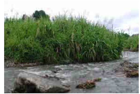
5. Creepaers 橋 渡河用のコンクリート構造物が破壊されて残っている。
