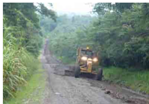
写真 2-2 降雨後の路面補修
