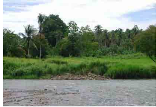
14. Irung 橋 旧橋へのアプローチ道路、既に雑草に覆われている。
