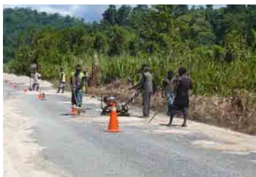
写真 2-1 ポットホールの補修
