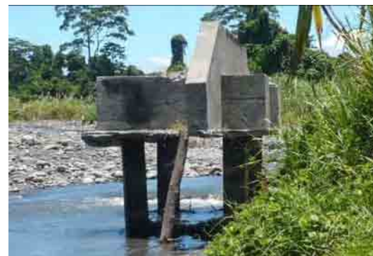
写真 2-4 Iraka 橋（取り残された橋台）
