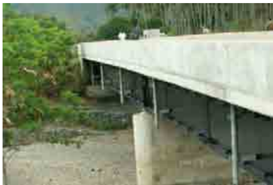
写真 2-7 ビティジャ橋の現況
