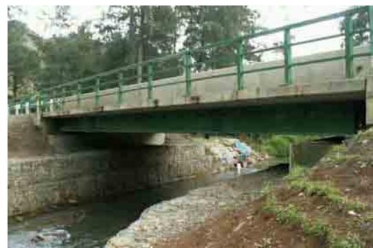
写真 2-8 ハイランド橋梁の現況
