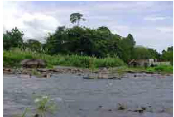
7. Iraka 橋 破損した下部工構造物が残存している。
