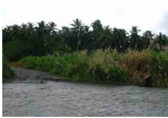
2. Bove 橋 右岸側を望む。河床渡河のためのアプローチ道路が見える。
