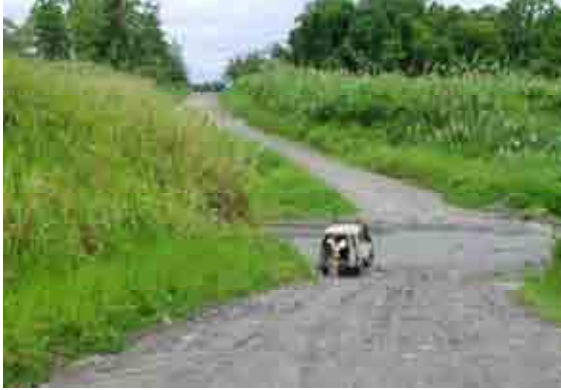
4. Pukarobi-2 橋 架橋予定地点全景
