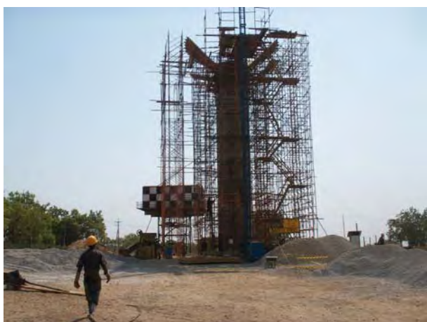
4. ギャラン広場で建設中の高架水槽
