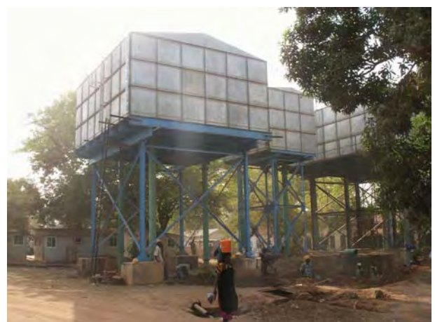
5. 病院横の高架水槽
