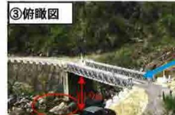
既設橋の桁下は約 9m。橋台付近には岩盤が露出しているのが分かる
