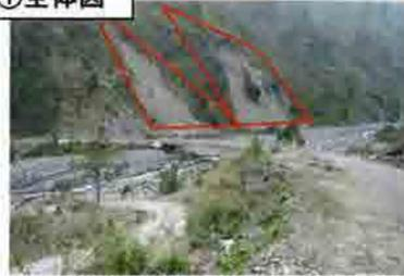
既設橋の背面に崩壊を繰り返す崖錘層が見える。そのため、山側のAルートは安全上避けるべき。
