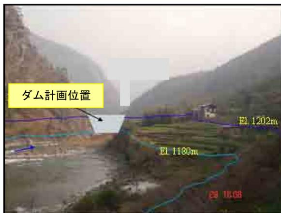
図 3-9 プナチャンチュダム計画高水位・低水位
