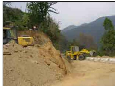
図 3-4 急カーブの拡幅状況
