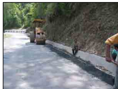
図 2-9 舗装補修の様子 (ダンプー付近)
