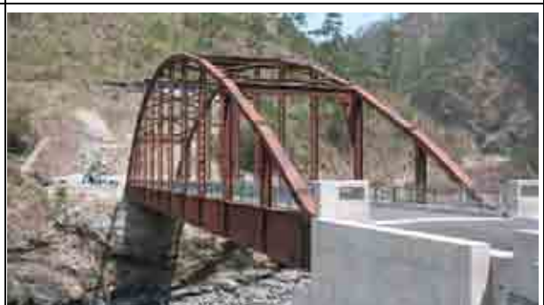
写真 16：ワクリタル橋・本プロジェクトの設計に反映するため、第二次計画の橋梁の状況を調査した。
