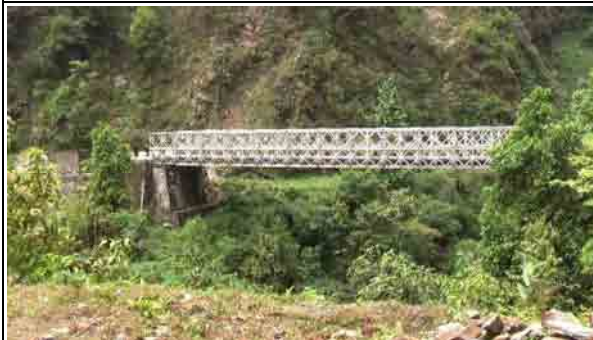
写真 11：ローリン橋の全景
