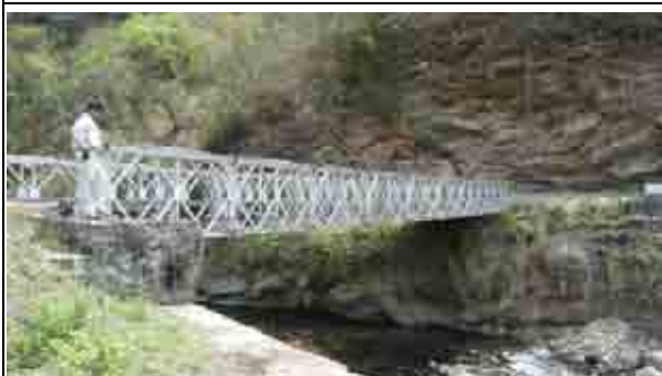
写真 7：ブリチュ橋の全景
