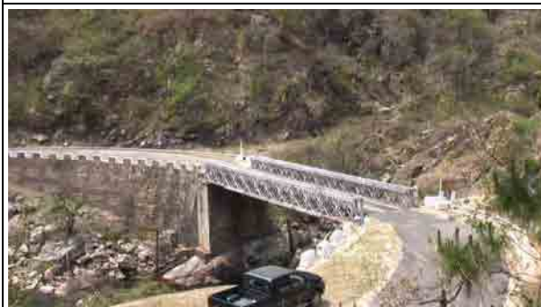
写真 3：バスチュ橋の全景
