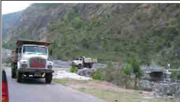
写真 13：ニャラチュ橋・国道 5 号線の通行車両は写真のようなトラックの他、マイクロバス、タクシー（軽ワゴン）、一般車両の通行が見られる。
