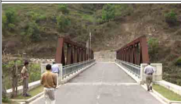
写真 15：ワチーザム橋・本プロジェクトの設計に反映するため、第一次計画の橋梁の状況を調査した。
