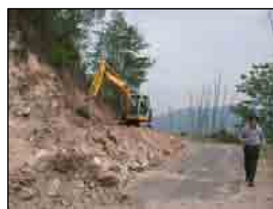
図 2-8 道路拡幅の様子 (ダンプー付近)
