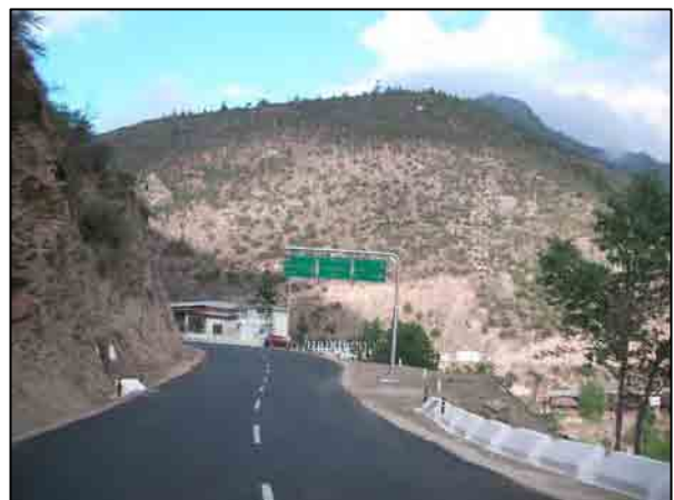
図 1-7 GOI が整備した道路(ティンパーパ間)
