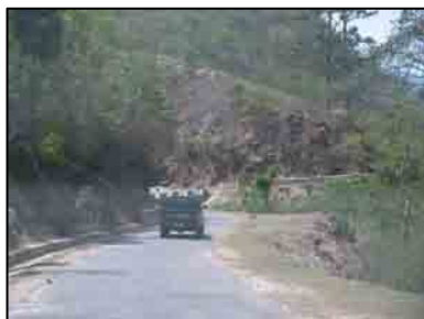
図 2-5 1.5 車線の道路幅員 (バスチュ付近)
