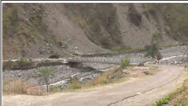
写真 5：ニャラチュ橋の全景
