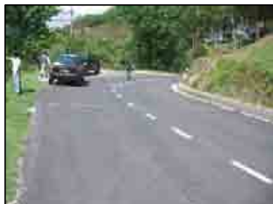
図 2-6 2 車線確保された道路 (ダンプー付近・幅員 6.5m)
