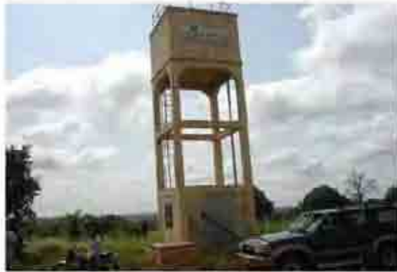
写真7 小規模給水施設の給水塔
