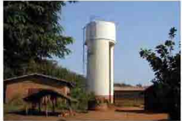
写真8 小規模給水施設の給水塔
