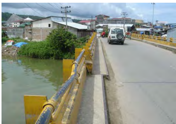
Nou 橋 上部工移動による路面のギャップ
