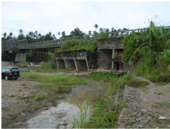
Idano Gawo 橋 ベアリー仮橋による応急的復旧
