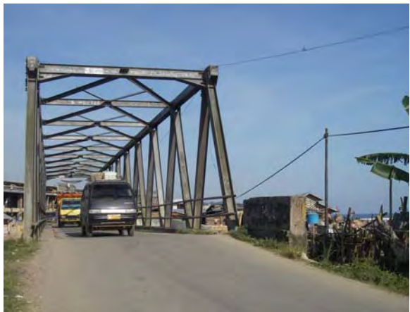
Nou A 橋 1 車線幅員 (4.5m) トラス
