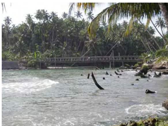
Sa'ua 橋 ベアリー仮橋
