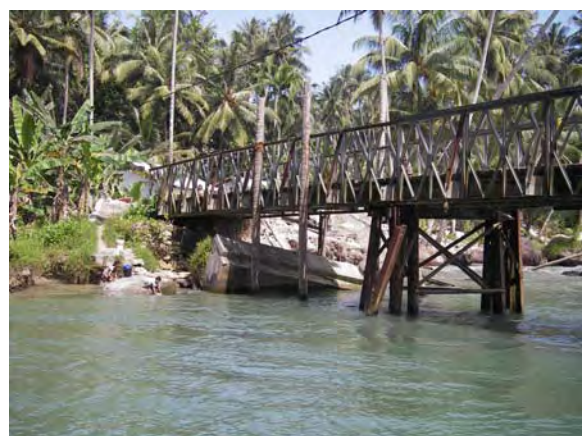
Sa'ua 橋 ココナツ木による仮補強
