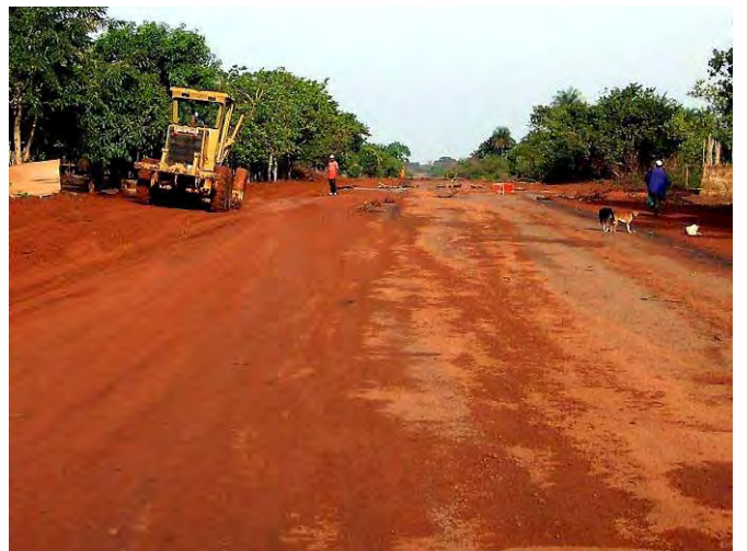
EU の支援で実施されている道路改修工事 (ケボ近郊)
