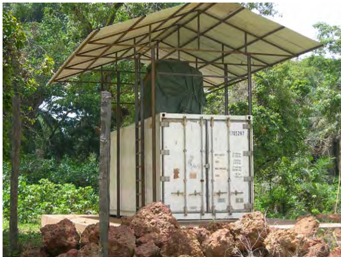
カシーン村に建設中の製氷設備 (ADIM)
