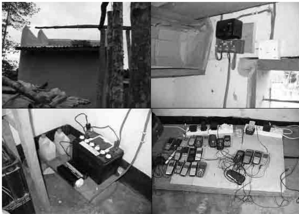
図 4-4 商店が設置した SHS（携帯電話の充電サービスを行っている：ウガンダ地方部）
