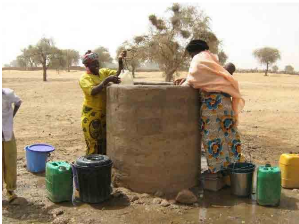
写真-7 コンクリートブロックあるいは鉄筋コンクリート製の土留め壁を埋設した浅井戸、水源は浅層地下水で、必ずしも安全ではないが、右の写真に示す通り前記の伝統井戸よりはよい。(ティラベリ県レムドベリ村)
