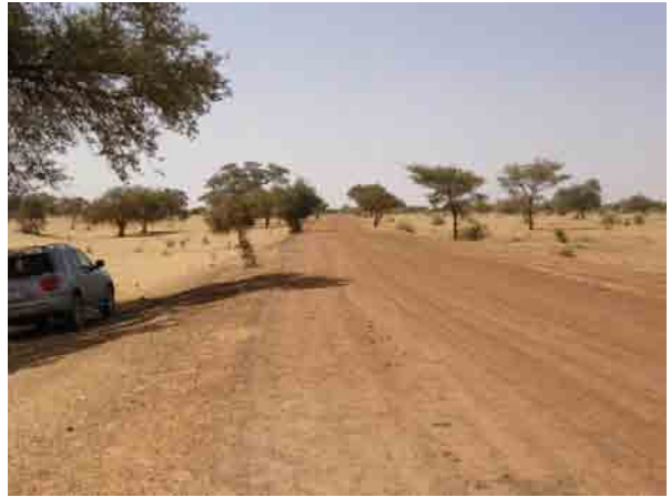
写真-14 ラテライト舗装の地方幹線道路、大型車両の走行に支障はない。
