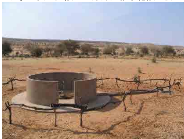
写真-12 我が国のザンデル案件で建設された深井戸、村民が周囲に柵を作っている。
