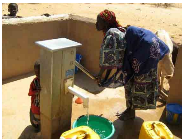
写真-10 手押ポンプ付き深井戸 (ティラベリ県 Ti-72)
