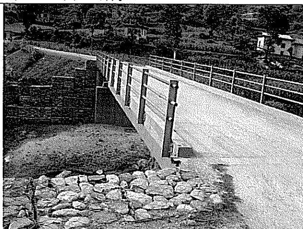
既設のコースウェイ。ヒューム管と越流の併用 (ラメチャップ郡)。
