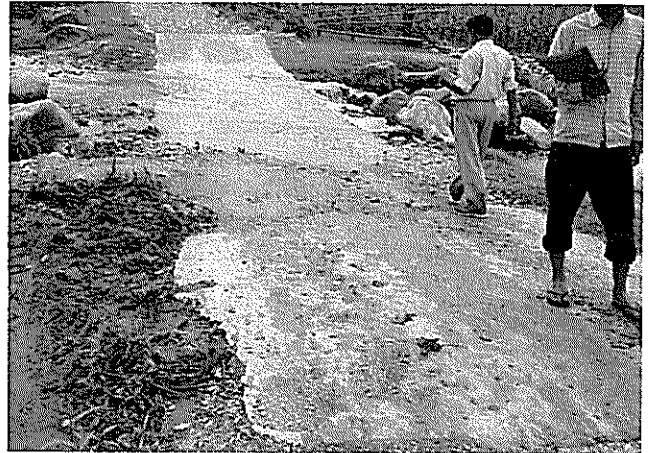
既設のコースウェイ (川幅約3m)。リハビリが必要となっている (シンズリ郡にて)。
