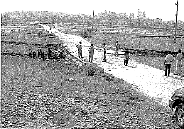
広い河川敷を横断するコースウェイ。河床の地形に合わせて凹凸が見られる (ヘタウダ市付近)。
