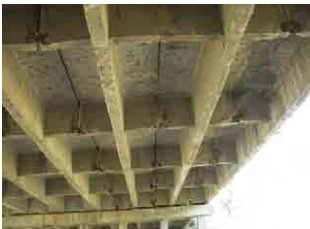
T型 プレキャストRC桁 (スパン14m) このタイプは桁相互を一体化できないため交通により損傷し易く、日本では使われていない
