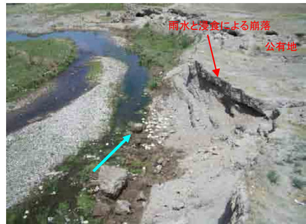
河川状況(下流側を望む) 自然の流れに任せて護岸は整備されていない
