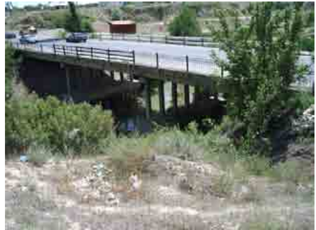
橋梁全景 下流左岸より橋梁を望む
