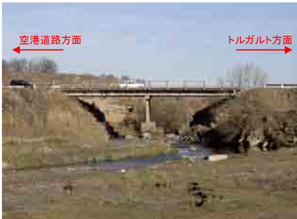
橋梁全景 上流右岸より望む
