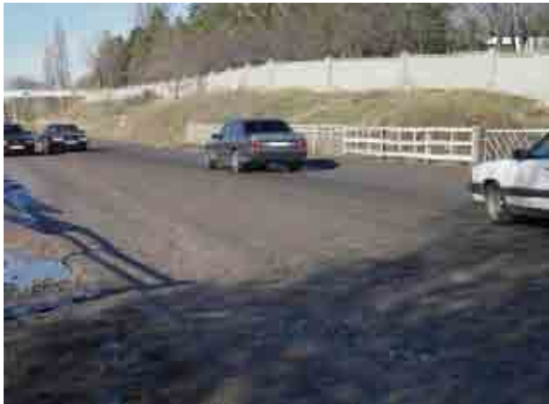
橋面状況 ポットホールが多数有り
