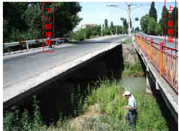
橋梁全景(上り線:対象外橋梁),下り線:対象橋梁) 下流右岸より望む
