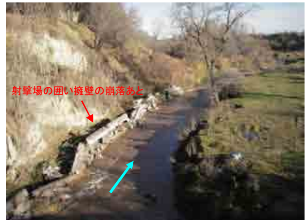
河川状況(橋梁より下流を望む) 左岸は崖地となっている
