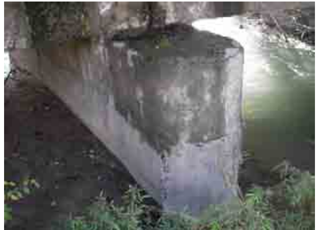
橋脚(下り線橋梁)
