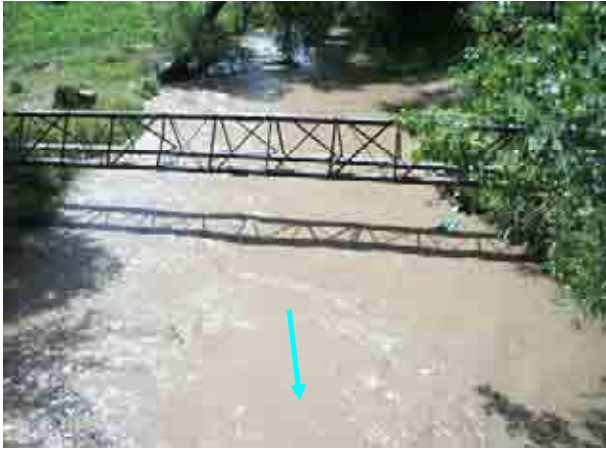
河川状況 上流側を望む
