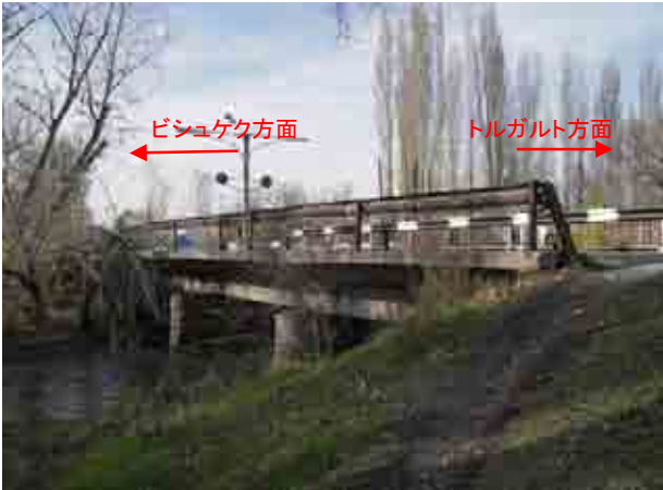
橋梁全景(下り線橋梁:対象橋梁) 上流右岸より望む
