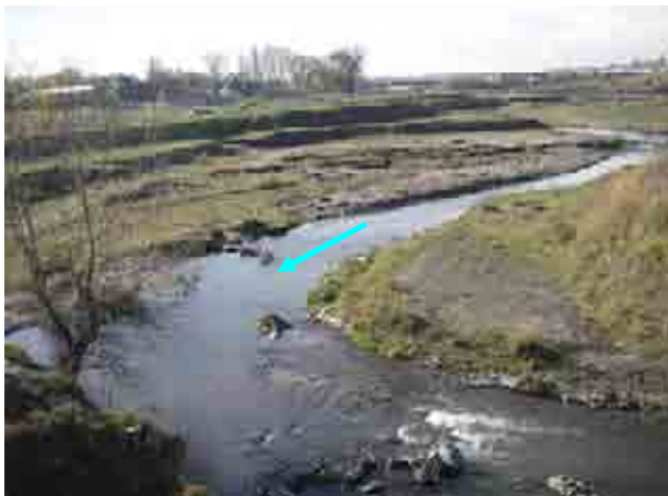
河川状況(上流側を望む)
