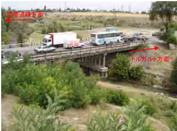
橋梁全景 上流左岸より橋梁を望む
