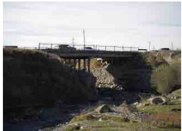
橋梁全景 下流左岸より望む
