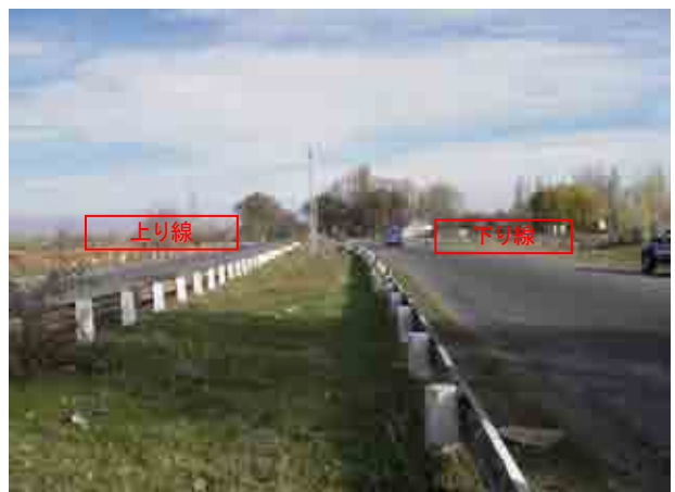
下り線と上り線の合流部(トルガルト方面を望む)
