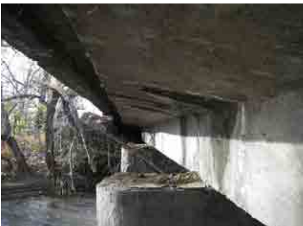
桁(下り線橋梁) 現場打ちRC造
