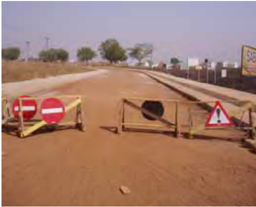
改修中の幹線道路(ユニティ-道路)
