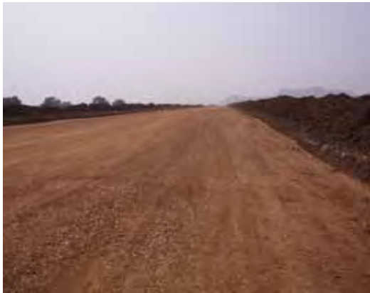
郭環状道路 ( 20km のうち、3km の土工工事が終了)
