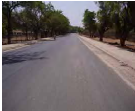
一部改修が終了した幹線道路(メイ道路)
