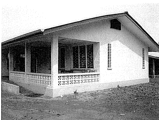
コミュニティセンター建設
