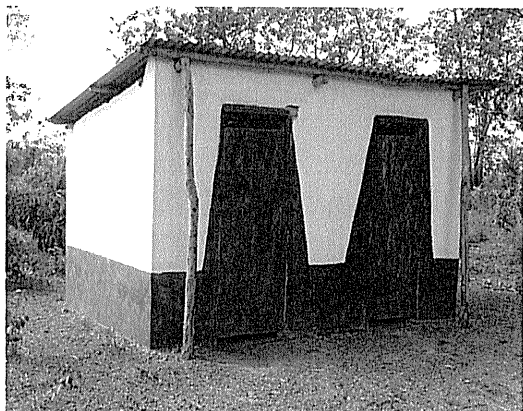
学校トイレ建設
