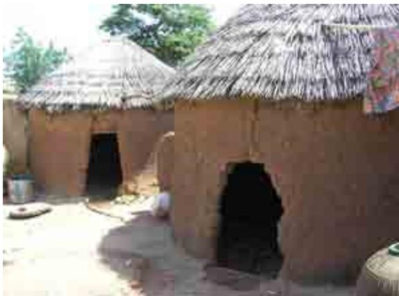
ガーナ、Tamale 近郊の農家の穀類貯蔵庫。壁、屋根をたくみに作り上げているが、土間に直接農産物を置くと、水分管理に問題が生じる。また、外部からの小動物などの侵入に対処できない。
