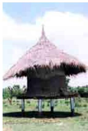
東アフリカの高床式貯蔵庫。床面は地表面より 50 cm 以上高く、さらに床面は竹を並べたスノコ状で、外部との通気性がよい。貯蔵庫を支える 4 本の柱はねずみ等が登れないよう工夫されている。
