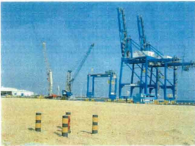
Sokhna港ガントリークレーン
