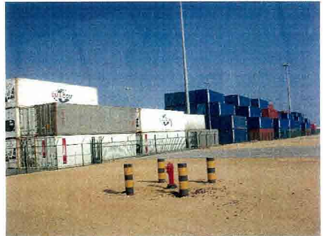
Sokhna港コンテナ置場
