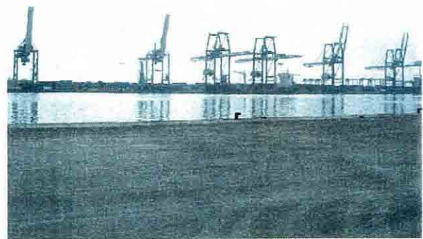
Damietta港ガントリークレーン
