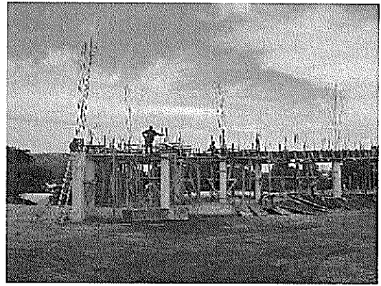
写真3-6 気象局に建設中の合同庁舎
