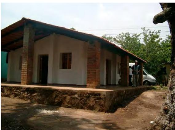
写真3：改良アドベ工法モデルハウス
