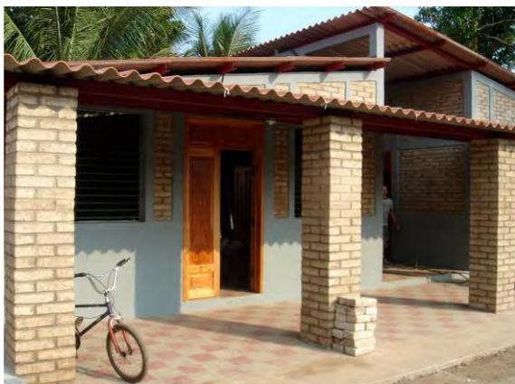
写真1：ソイルセメント工法モデルハウス
