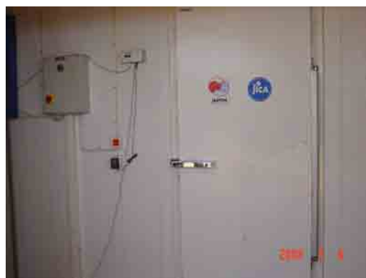
コールドルーム入口部分に貼付された協力マーク
