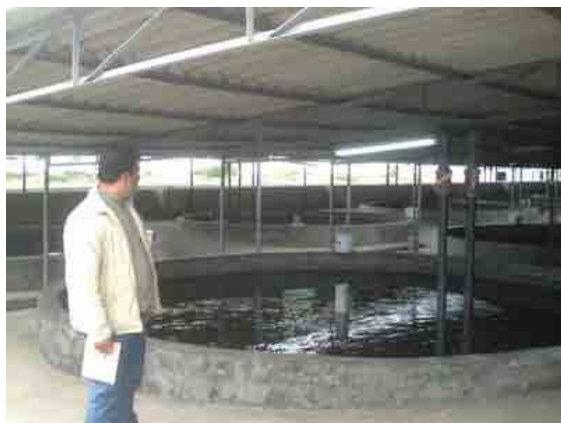
コンクリート製大型水槽 (18m 3 )
