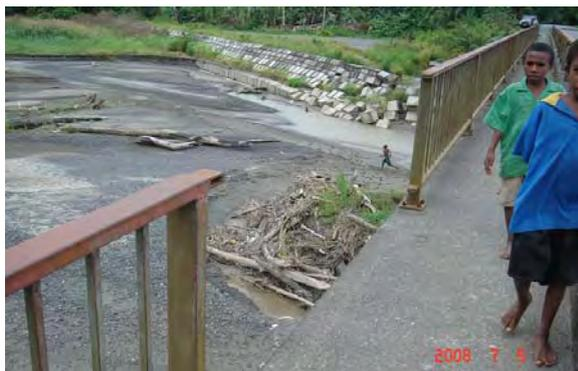
写真-11 手すりの欠損状況
