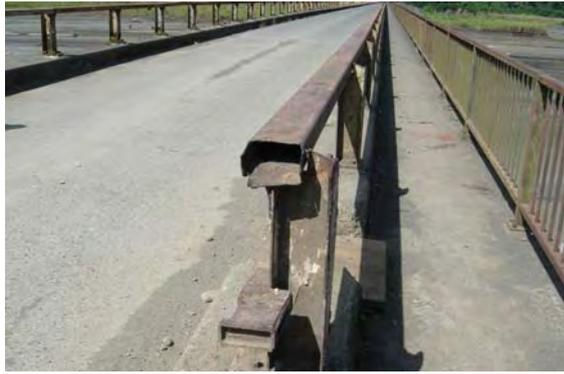
写真-7 ガードレールの損傷状況
