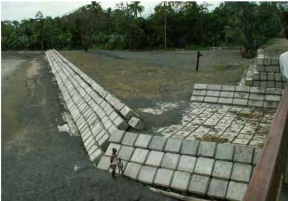
写真 3-1 2006年8月の上流側護岸工
