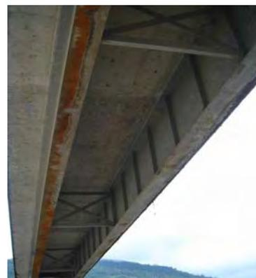
写真-6 鋼桁の錆の状況
