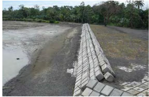
写真-8 レイ側上流の護岸工
