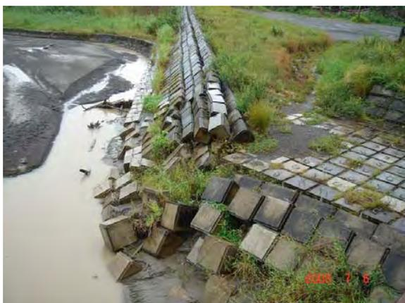
写真 3-3 2008年7月の上流側護岸工
