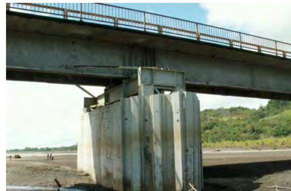
写真-4 P3 橋脚補修状況
