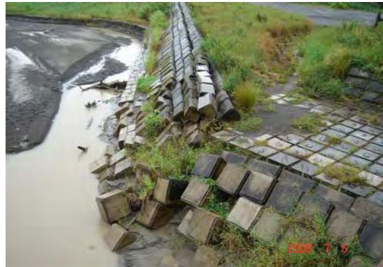
写真-10 レイ側上流側のブロック崩落
