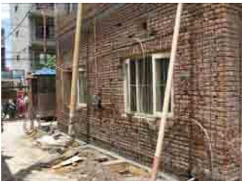
Chhatrapati のコミュニティ病院の耐震補強作業の様子、鉄筋等を使用して補強作業が行われている。
