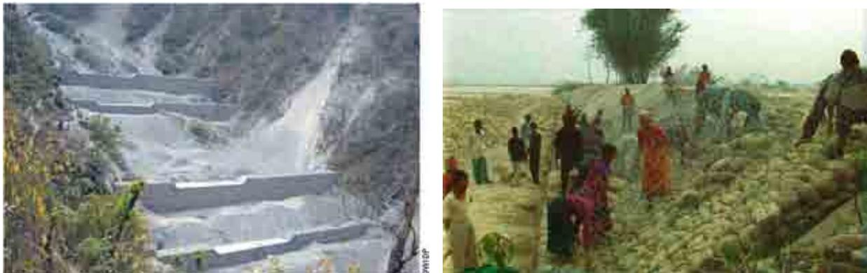
図 2.3.2 砂防ダム（左）とコミュニティによる布団かごを使った築堤作業（右）
