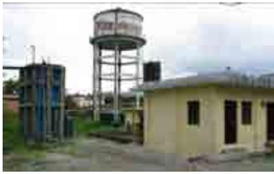
ラリトプール市にある耐震補強された給水施設、中央のタンクは耐震補強されていない、左の青いタンクは耐震補強済み、右の建物は耐震の給水施設
