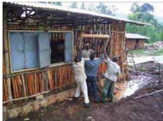
窓枠の取り付け
