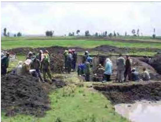
住民参加による溝掘り
