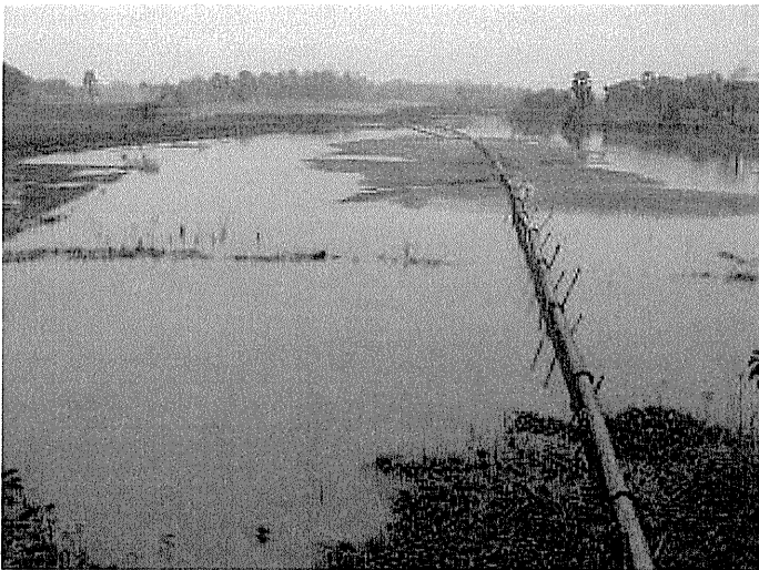
ダッカ市東部の宅地開発のための埋め立て工事現場
