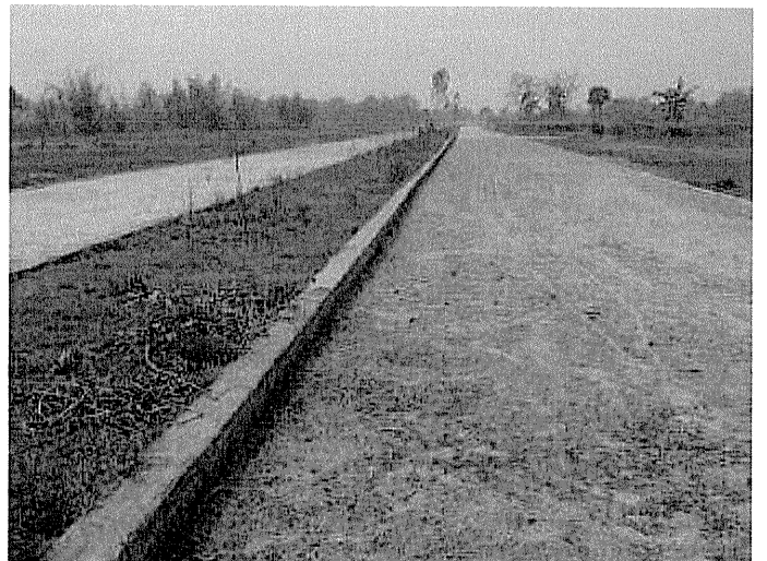
ダッカ市東部の衛星都市建設の工事現場
