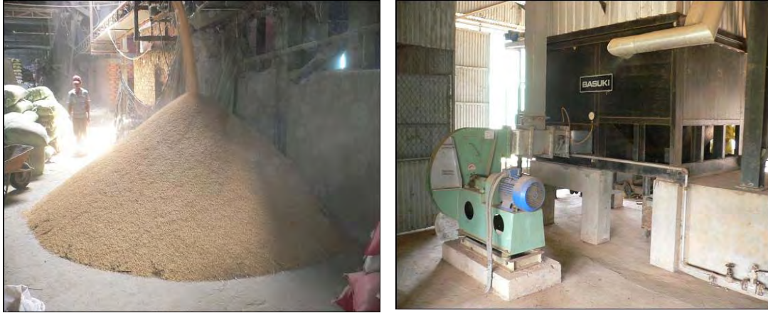
Hình 2.6-2 Vỏ trấu (trái) và Hệ thống đồng phát (tỉnh Long An, AUSAID)
