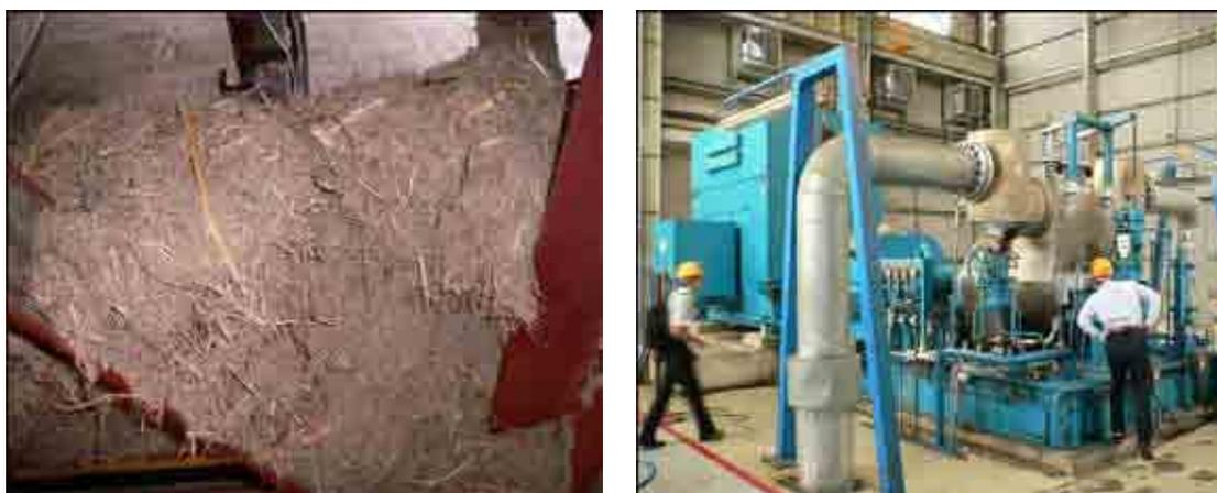
図 2.6-1 バガス(左)およびコジェネシステム(Sucrierie de Bourbon 製糖工場)
