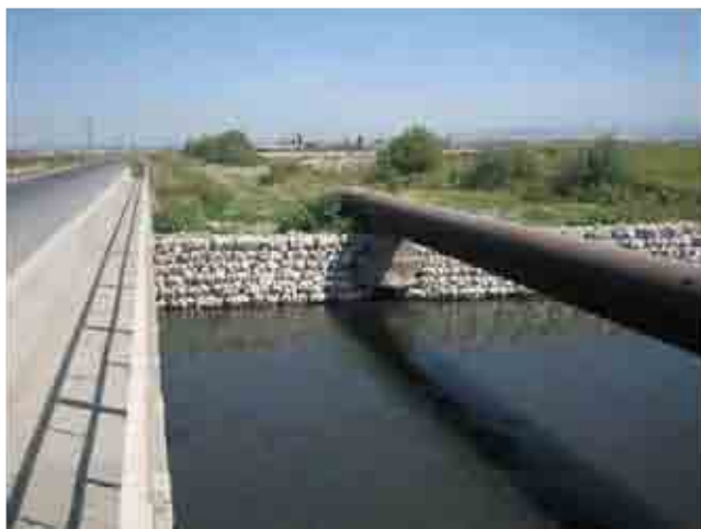
2007年9月13日 アラガツォトン州 見返資金プロジェクト 「ラズダン川洪水・農地浸水対策計画」における護岸工事
