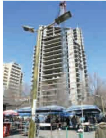
市内は町の至る所でビルの建築ラッシュ
