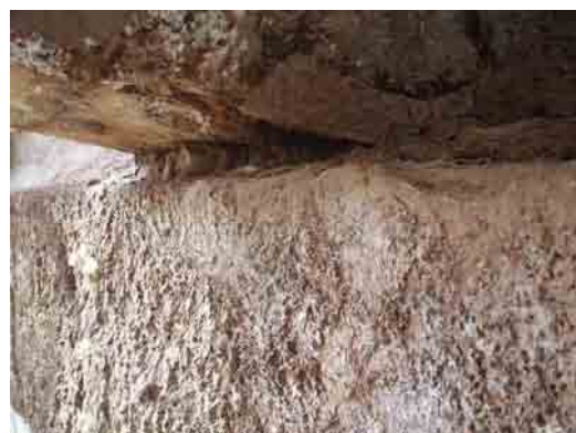
Photo 2.2.2-5 Béton de l'arc (2)
