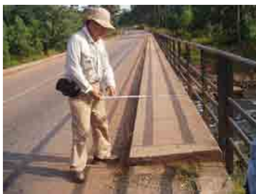
Photo 2.2.2.-1 Etude de la forme et des dimensions du pont
