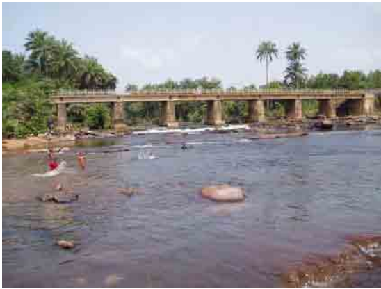
①橋梁全景（下流側より撮影）
