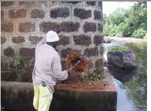
③下部工構造 ラライトブロック構造で中詰はラライト、基礎は岩着
