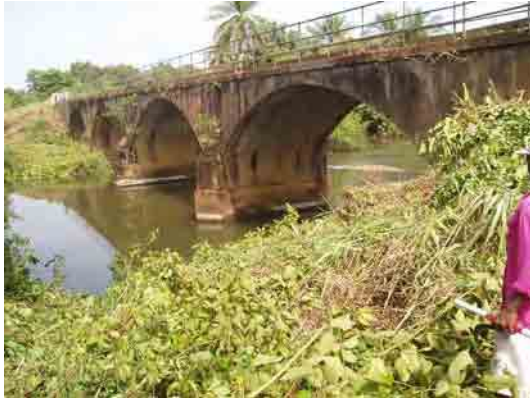
①橋梁全景（上流右岸より撮影）
