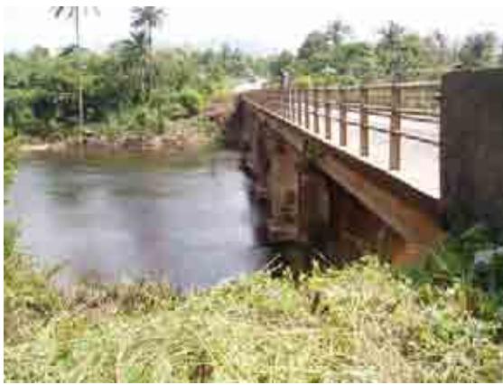
③河川の流況（上流側） 水深 1.5m 程度、流速 1.0m/s 以下
