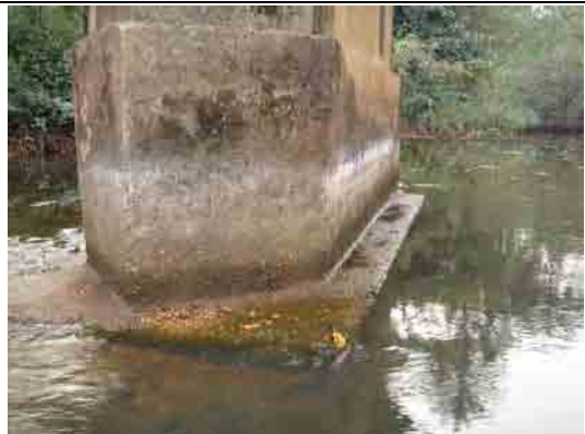
④橋脚の構造 基礎は岩着
