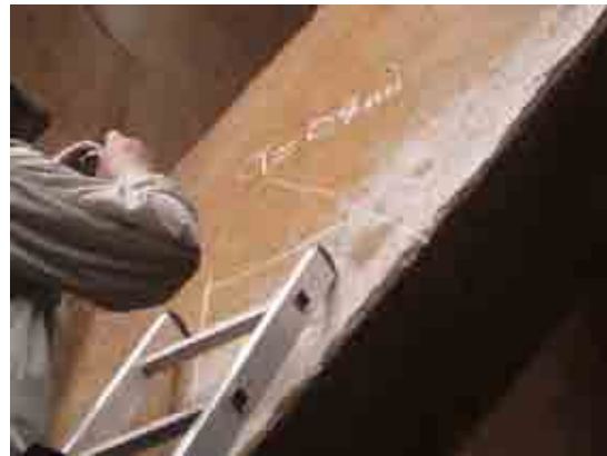
写真 3.2.2.1-4 クラックスケール調査
