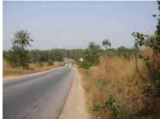
②コナクリ側アプローチ道路 橋梁までは下り勾配
