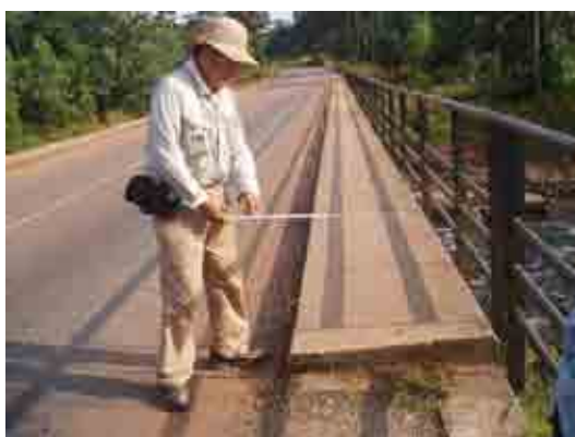
写真 3.2.2.1-1 橋梁形状寸法調査
