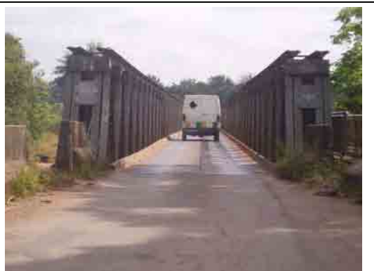
④路面状況 一車線橋として利用、路面は綫鋼板を敷設
