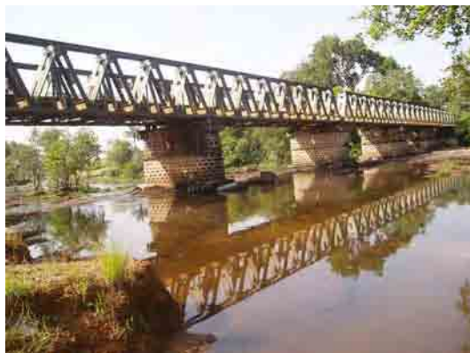
①橋梁全景（上流左岸より撮影）
