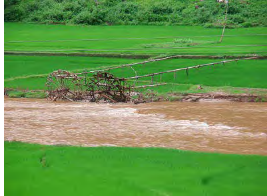
Thủy điện quy mô nhỏ bánh xe quay nước (h. Điện Biên)
