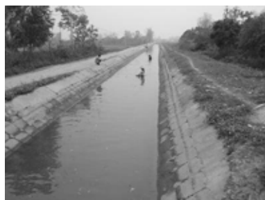
ライニングされた幹線水路
