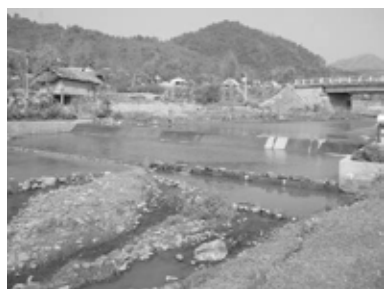
取水工(固定式コンクリート堰)
