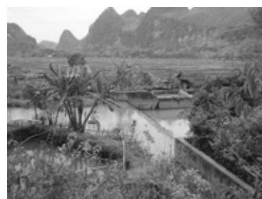
既存取水工（灌漑・給水）
