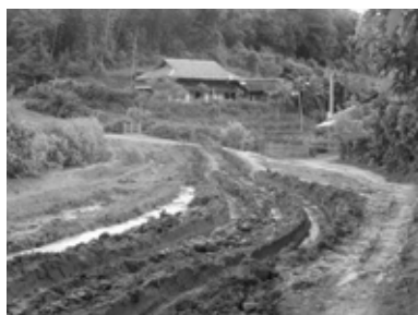
雨季には悪路となる農村道路
