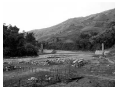
連絡橋を備えた取水施設
