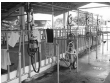
近代的な搾乳施設
