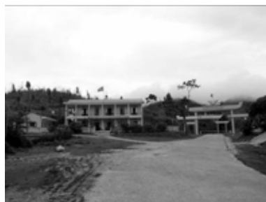
ベトナム国境ゲートの管理棟
