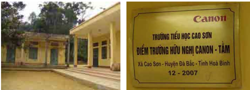
図 7.3.23 日本企業の支援により建てられた小学校(右)と旧校舎
