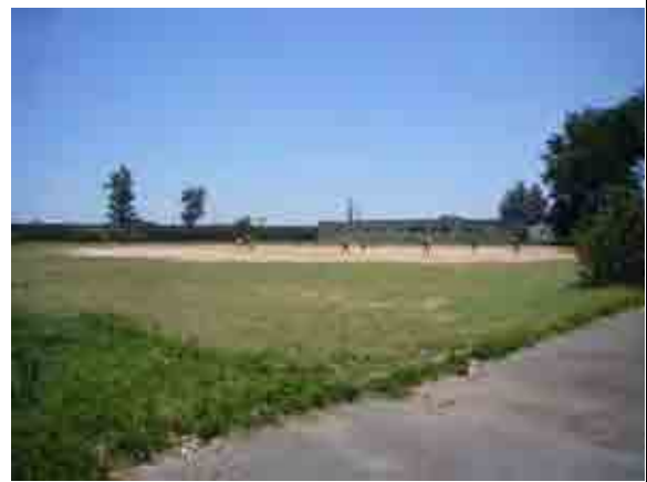
写真 22:CHUA 構内の駐車場から臨む建設サイト全景(サイト西北部分)。同駐車場の一部は建設仮設用地として病院より提供される。
