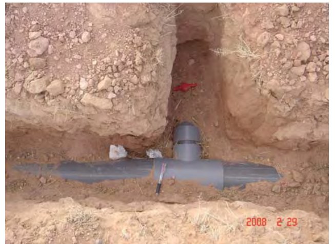
(16) 地下水揚水ポンプ
