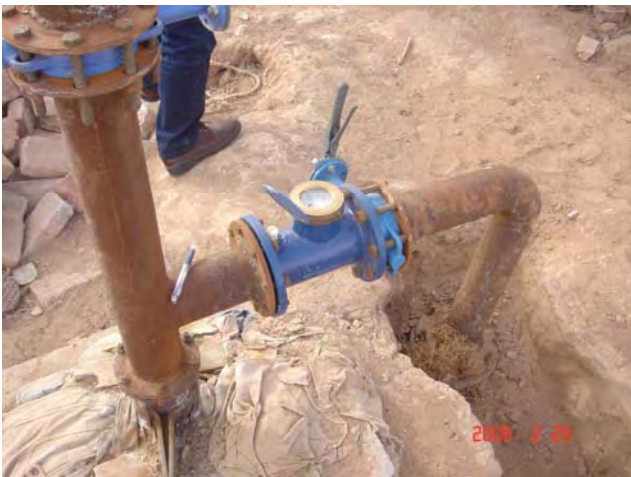
(15) 地下水揚水ポンプのパイプ直角分岐箇所（埋戻し前）。深さ約 100m、地下水位は約 30m。一日約 80 トンの揚水量。
