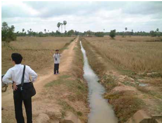
カンダラン地区 幹線水路沿いの二次水路
