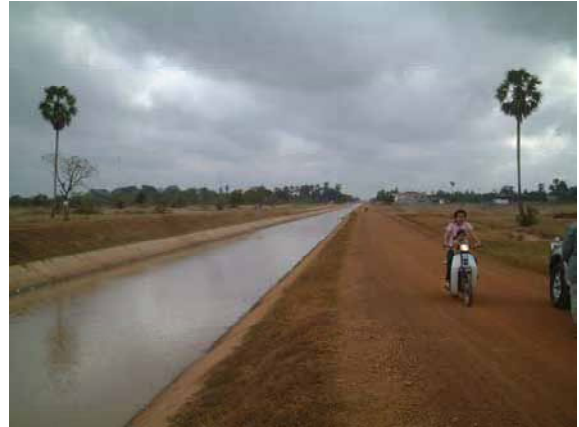
カンダラン地区 無償資金協力により建設された幹線水路
