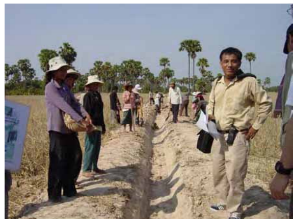
プルサット地区 農民による末端水路工事
