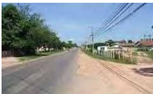
損傷した舗装端と路肩
