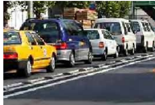
舗装面より高い中央分離施設
