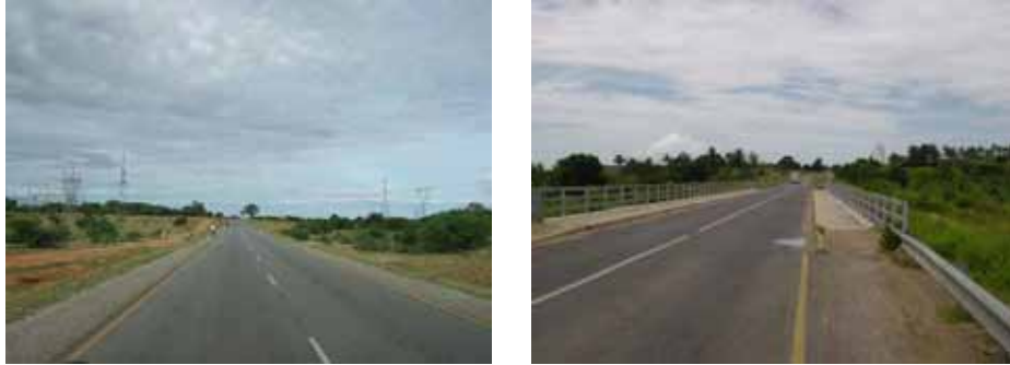
図 2.2.2 ニューバガモヨ道路改修工事
