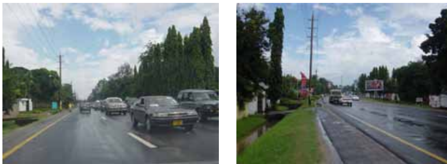
図 2.2.1 ニューバガモヨ道路暫定拡幅工事
