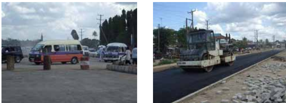
図 5.3.2 ムウエンゲ交差点改良工事
