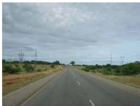
図 5.1.3 テゲタ～ムピジ間の路面状態
