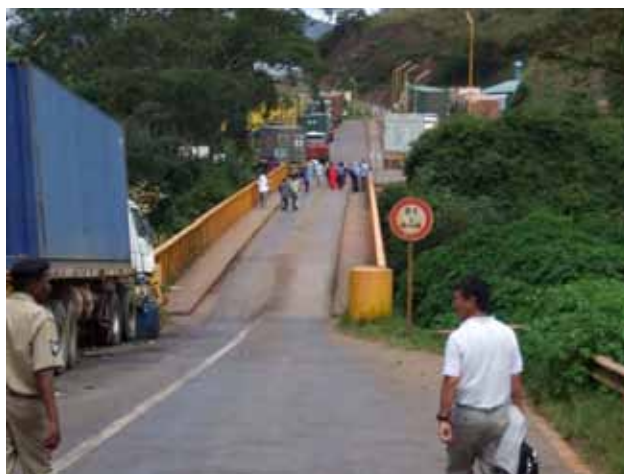
図 2.2.2 ルスモ橋(1車線で荷重制限がある)
