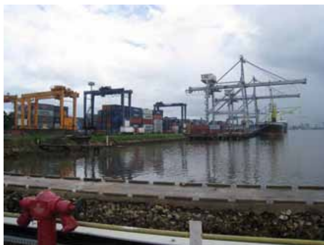
図 2.2.5 ダルエスサラーム港のコンテナターミナル
