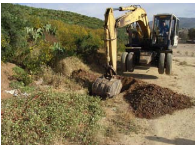
敷地傾斜中腹を試掘
