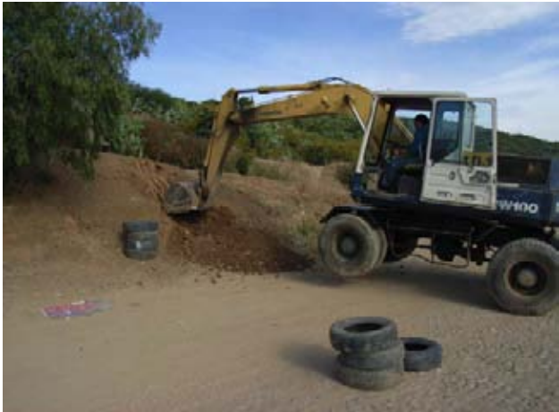
敷地傾斜下部を試掘
